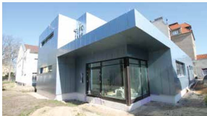
Der Neubau für das Gymnasium schreitet gut voran
