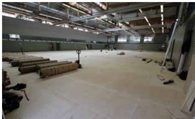
Umfangreiche Sanierung des 20 Jahre alten Sportbodens
